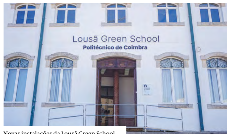
Novas instalações da Lousã Green School
