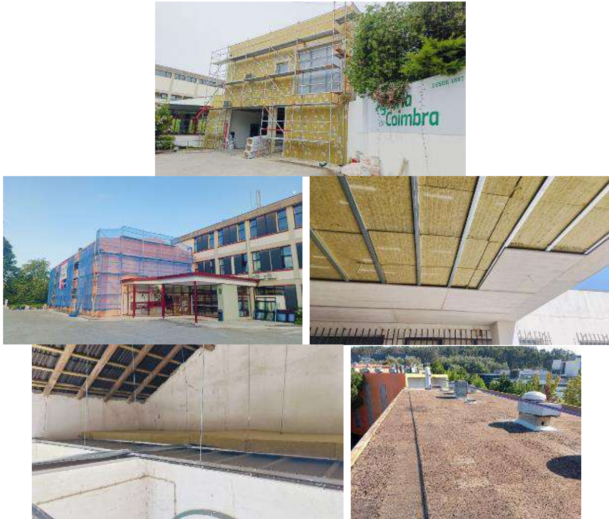
Figura 23. Aplicação de isolamento térmico em fachadas, telhados e pavimentos para reduzir o consumo de energia e melhorar o conforto térmico
