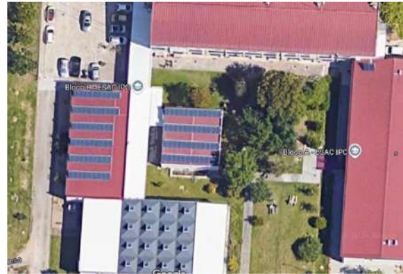
Figura 17. Solar painéis fotovoltaicos – Campus ESAC/ISCAC
