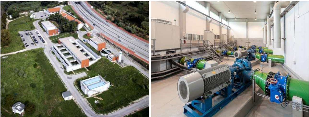
Figura 8. Estação de Tratamento de Água da Boavista, Coimbra
