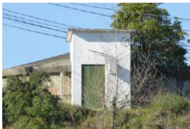
Figura 19 - Tanque de água para rega, abastecimento de hidrantes e autoclismos ( Campus da ESAC)
