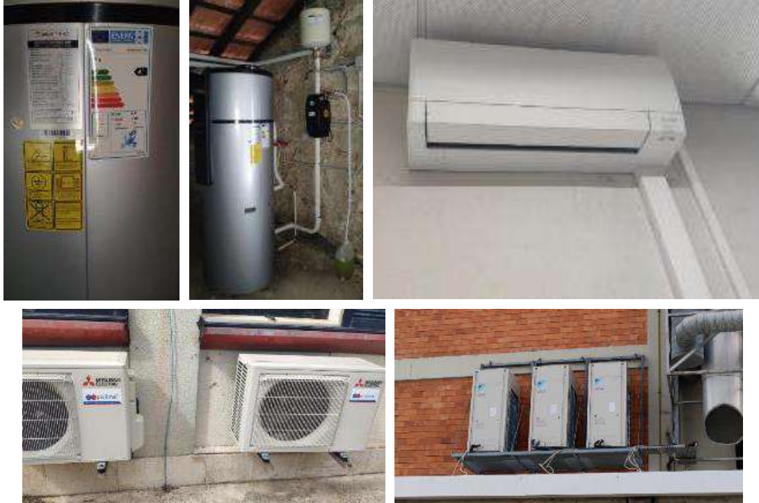
Figura 24. Substituição dos sistemas de AVAC e AQS para reduzir o consumo de energia e melhorar o conforto térmico
