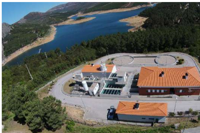
Figura 9. Estação de Tratamento Oliveira do Hospital
