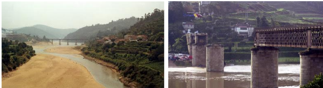
Figura 1. Ponte Hintze Ribeiro: vale e areal do Rio Douro e estado da ponte após o colapso
